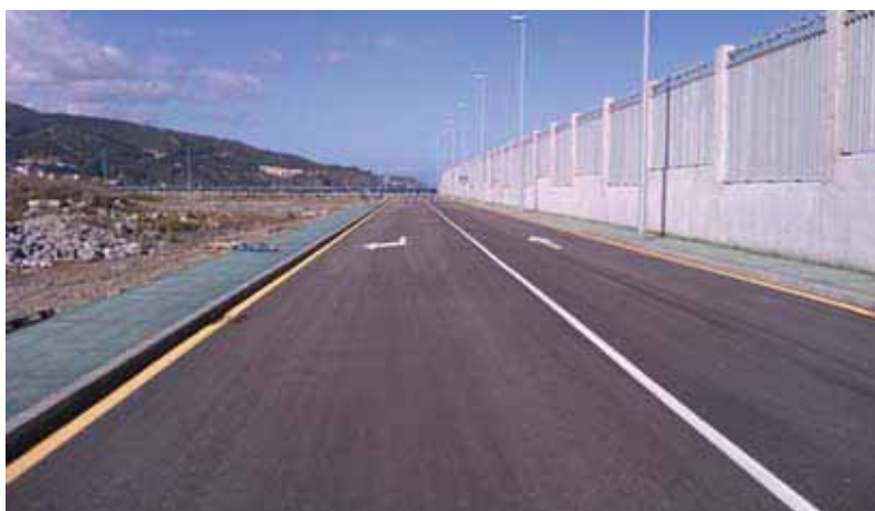
Vista general zona industrial (viales)
