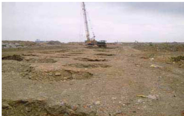
Compactación dinámica en viales
