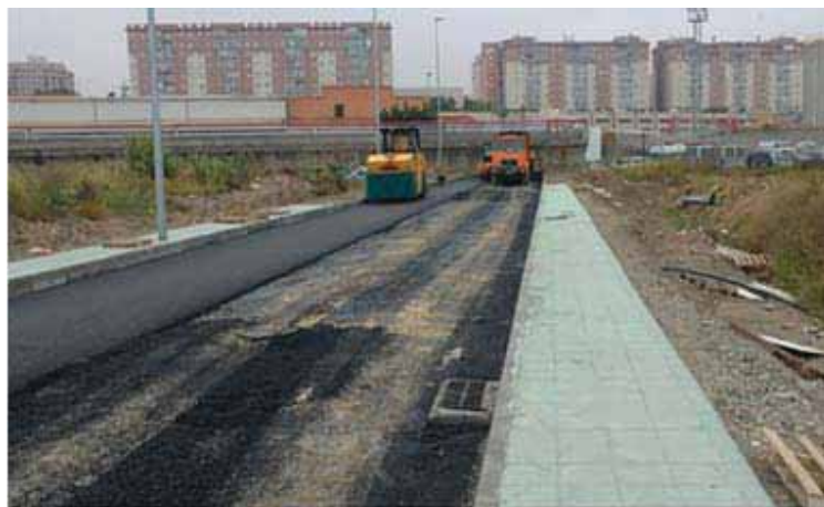
Extendido de aglomerado en viales
