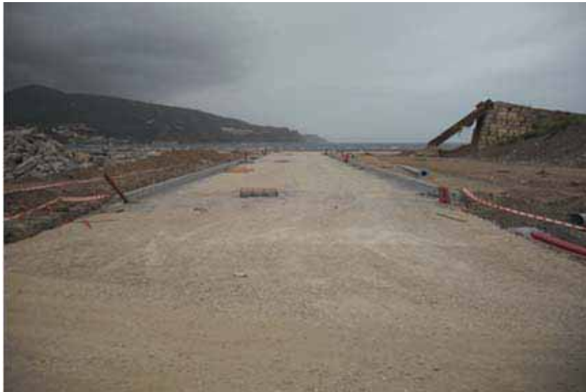
Ejecución de infraestructuras en viales
